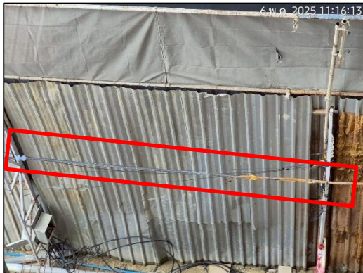
ภาพที่ 11 หัวฉีดสเปรย์น้ำ (Spray Nozzles) ติดตั้งที่รั้วชั่วคราว
